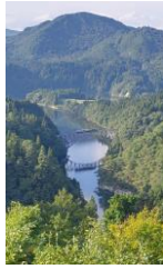
只見線第一只見川橋梁
